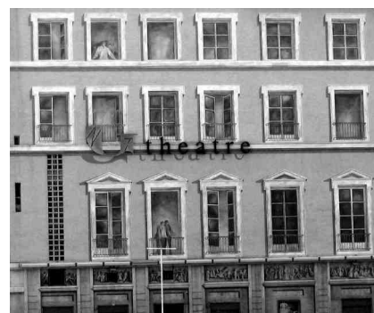
(Vue depuis la rive droite)
