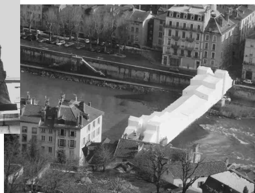
(Réfection de la passerelle St Laurent)
